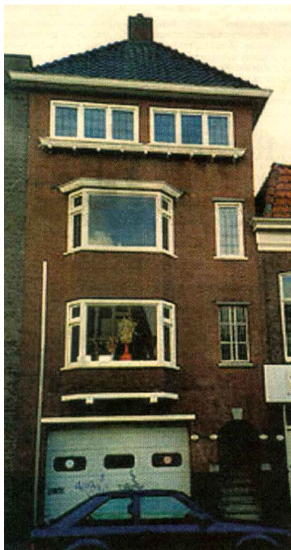
Entree voor de verbouwing
